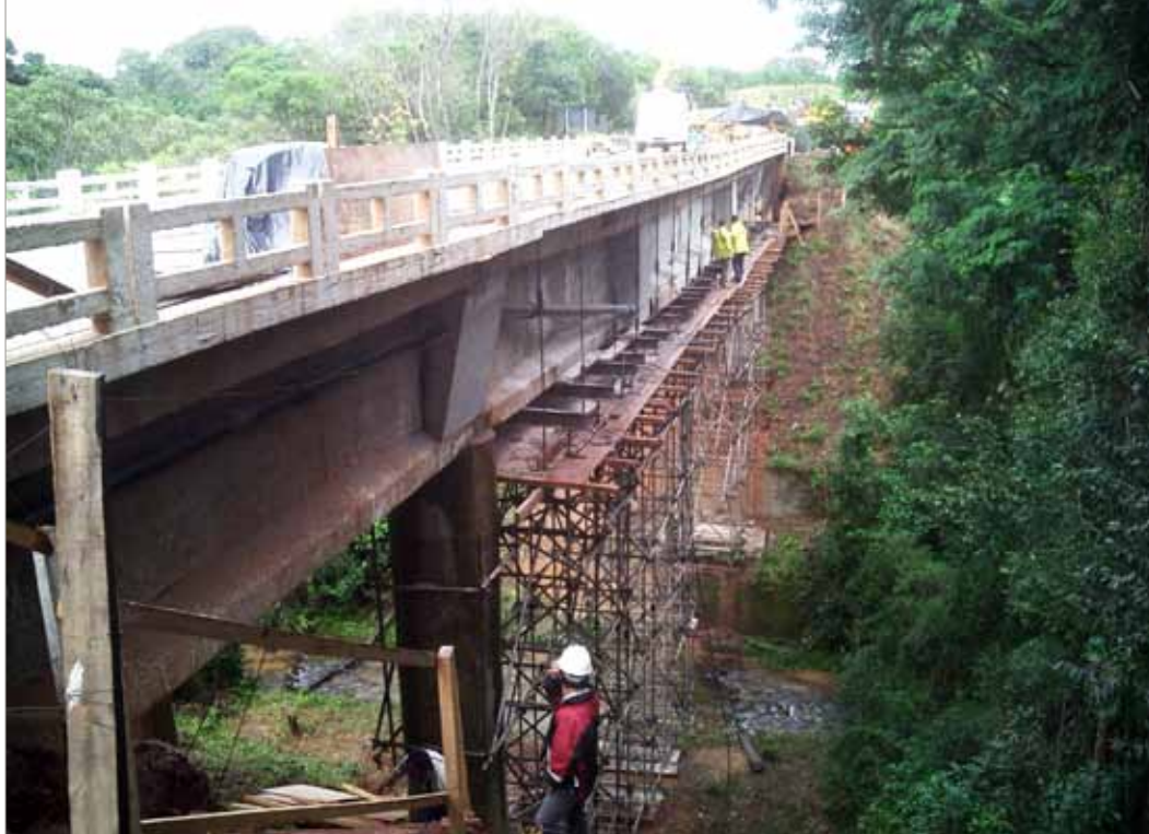
Ponte sobre o Rio Samambaia – Rodonorte – recuperação e reforço de ponte
